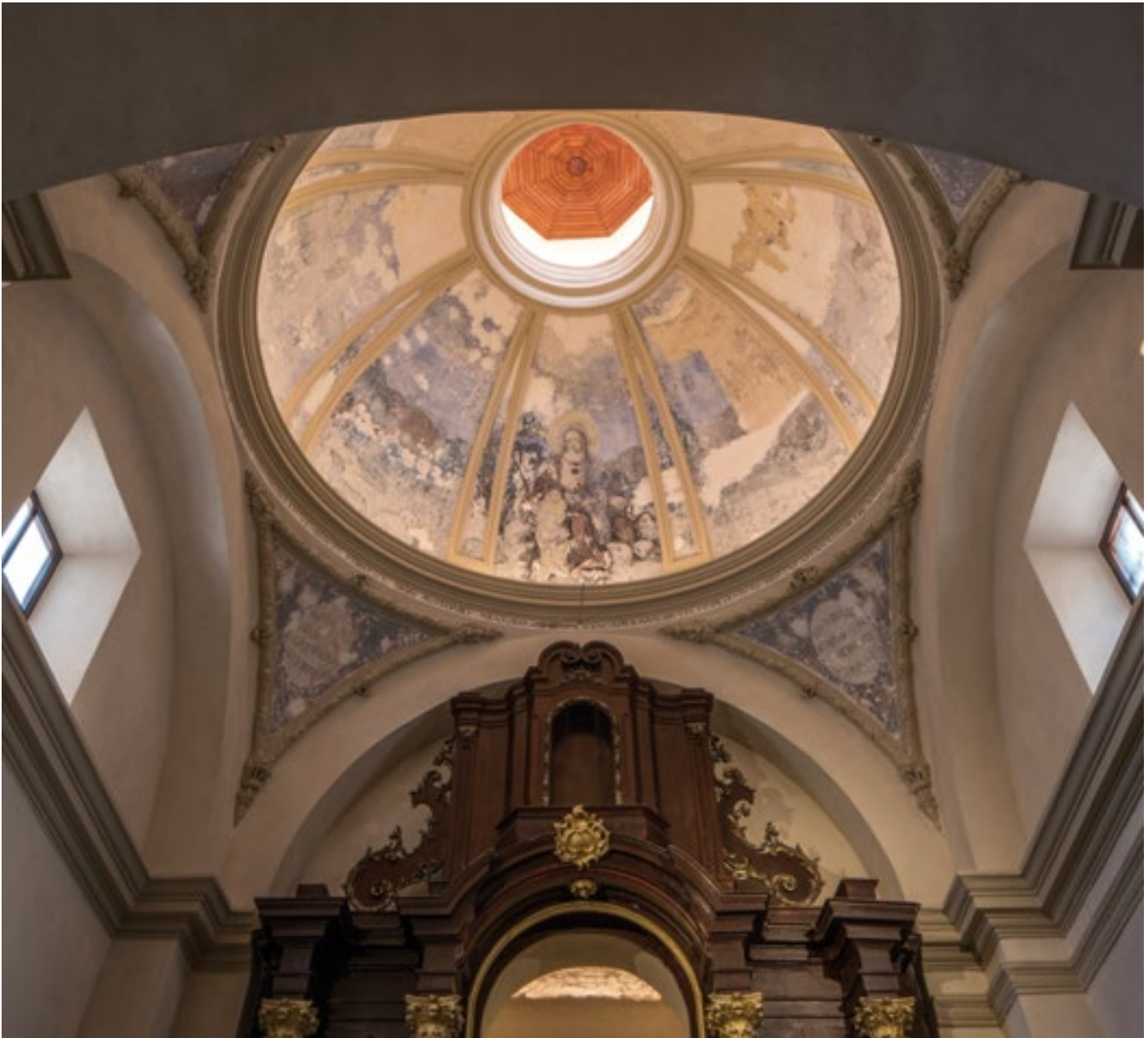
El equipo de DCI consideró fundamental crear distintas escenas lumínicas para resaltar los detalles arquitectónicos en función de las necesidades eclesíásticas, de las visitas y de la incidencia de la luz natural.
